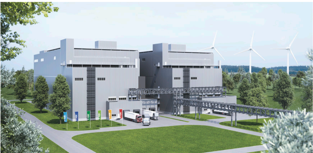
Die Anlage zur Produktion von Kathodenmaterial soll 2022 den Betrieb aufnehmen.
