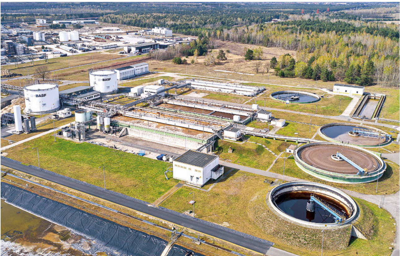
In der zentralen Abwasserreinigungs-Anlage (ZARA) werden Abwässer in einem mehrstufigen Verfahren aufbereitet.
